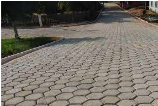
Imagem 1: Exemplo de calçamento com blocos de concreto sextavado
